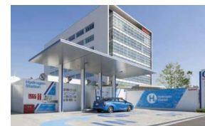
中規模 水素ステーション
